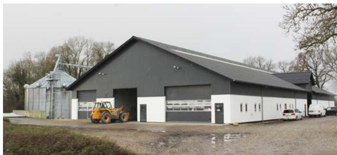
Maskinladen er indrettet med værksted, hvor maskinerne vedligeholdes
