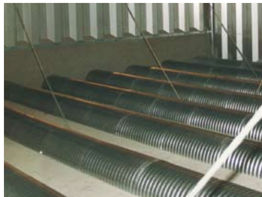
Rundbuekanaler udlagt på gulv
